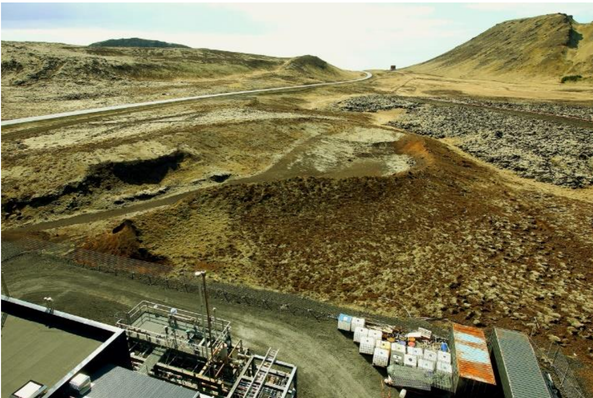
Mynd 11 Tekið úr turni verksmiðju til suðurs. Sýnir syðsta hluta lóðar, land sunnan hennar og Grindavíkurveg. Slóðinn sem sést við suðausturhorn lóðar er gamall og hefur væntanlega verið lagður vegna efnistöku, sem sjá má á miðri mynd. Þetta rask er alls óviðkomandi framkvæmdum CRI. Mynd: Gunnar Þórðarson, 20.05.2016.
