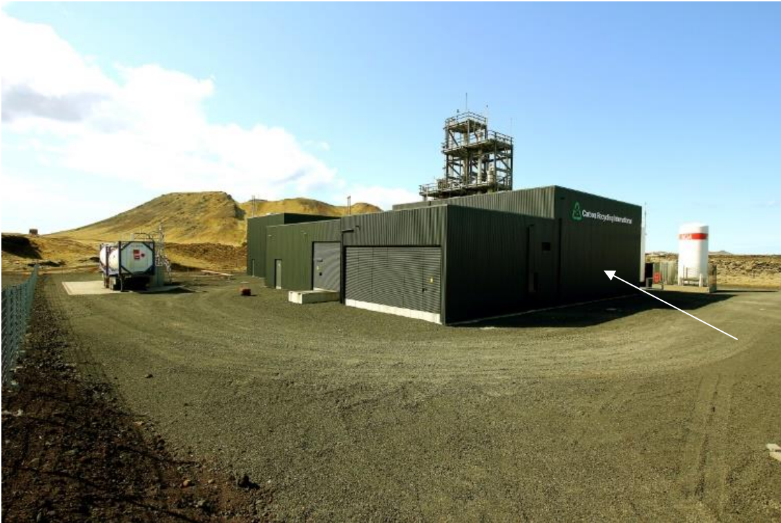
Mynd 8 Norður- og austurhlið verksmiðju og lóðar, tekið til suðurs meðfram girðingu á austurhlið. Fremst á myndinni er viðbygging verksmiðjuhúss til norðurs (ör). Einnig má sjá steipt plan við metanólálfyllingu. Mynd: Gunnar Þórðarson, 20.05.2016.
